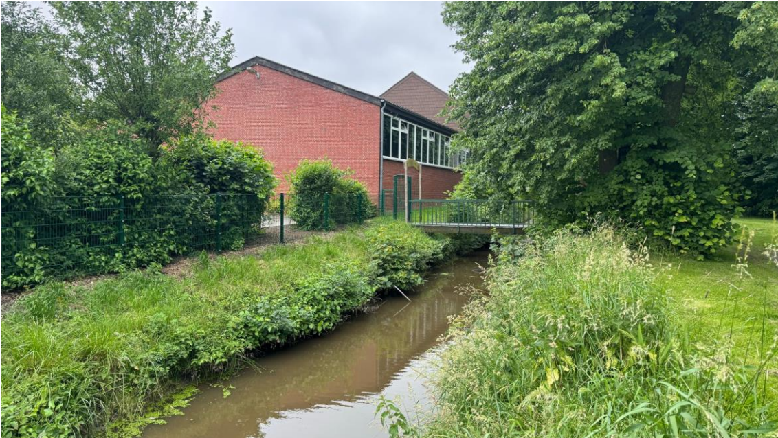
Abb. 15: Süder Wasserzug, im Hintergrund ein bestehendes Schulgebäude. Am rechten Ufer liegt das Bebauungsgebiet. Blick nach Norden. Aufnahme: 31.05.2024 (P. Hertrampf)
