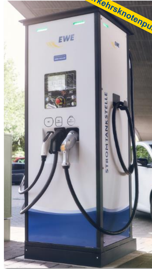
Gleich- und Wechselstrom Ladesäule 1 x 50kW CCS und 1 x 50kW Chademo 1 x 40kW Typ 2
